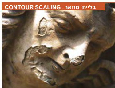
SPALLING . שיבוב
