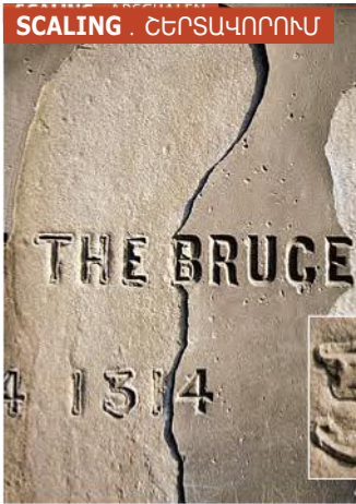
CONTOUR SCALING . ԵԶՐԱԳԾԱՅԻՆ ՇԵՐՏԱՏՈՒՄ
